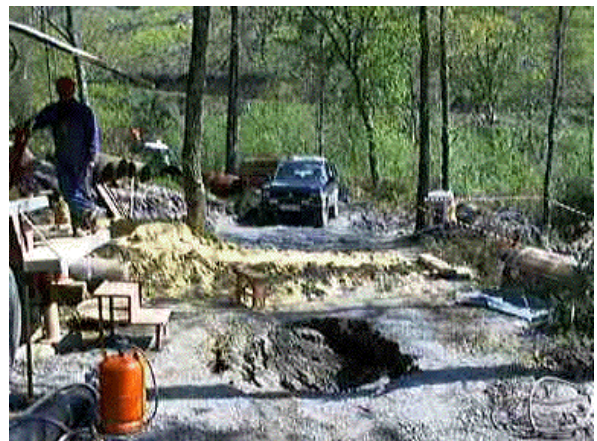
Hundimientos en el sondeo IBARRURI-Abis.
