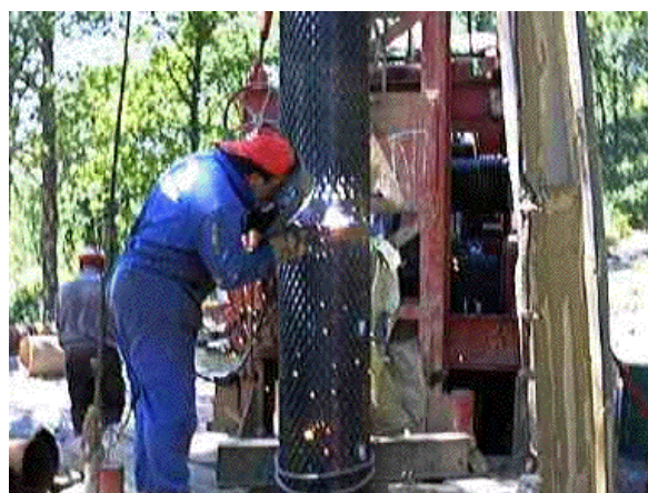
Entubando el sondeo IBARRURI-Abis
